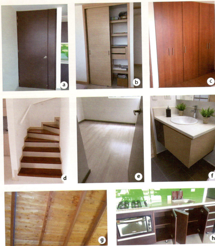
Fotografía 6. Usos de la madera en la fase de acabados (en la construcción). a) Puerta en tableros de partículas con terminado melamínico; b) Muebles empotrados; c) Muebles de alcoba; d) Escaleras; e) Piso laminado; f) Muebles de baño; g) Cielo rasos; h) Muebles de cocina, en tableros de partículas con terminado melamínico
