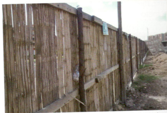
Fotografía 9. Cerramientos hechos con esterilla de guadua y varas de madera rolliza
