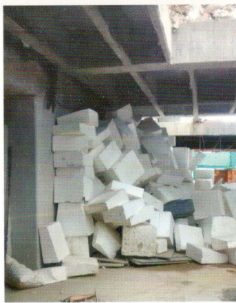
Fotografía 3. Bloques de icopor utilizados como casetones para placa, reemplazando el casetón de madera
