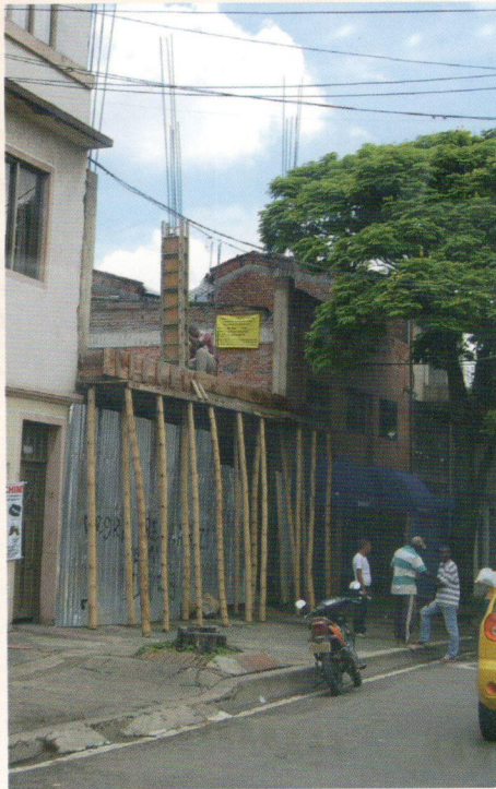
Fotografía 10. Varas de guadua utilizadas como parales para fundición de placa
