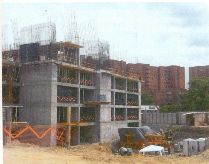
Fotografía 1. Sistema Outinord (construcción industrializada)
