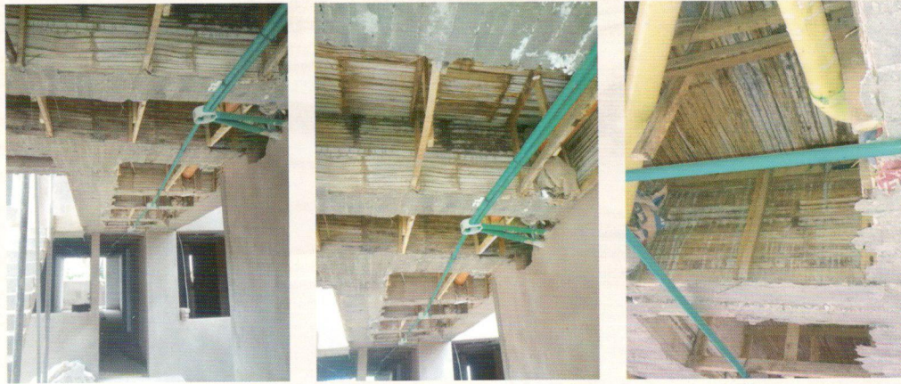
Fotografía 2. Casetones en guadua y estructura de madera, utilizados para fundir la placa y dejados posteriormente en la construcción
