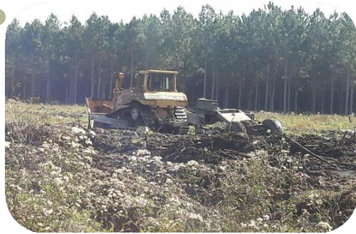
Preparación de terreno
