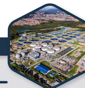
Foto: Planta de tratamiento de aguas residuales para la ciudad de Bogotá, Colombia /wamayar
