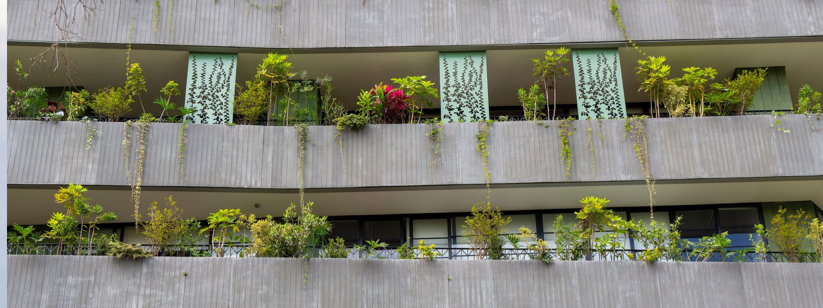
Foto: Fachada vegetal de un edificio residencial del barrio de Poblado, Medellín, Colombia / Bruno M Photographie
