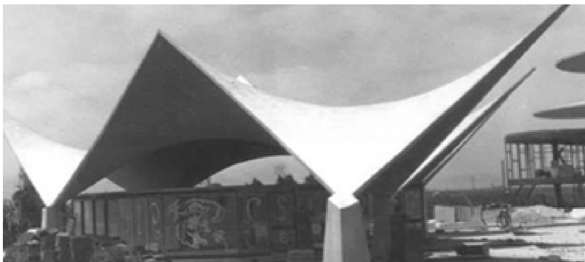
Figura 18. Cubierta paraboloides hiperbólicos El Rebollet
