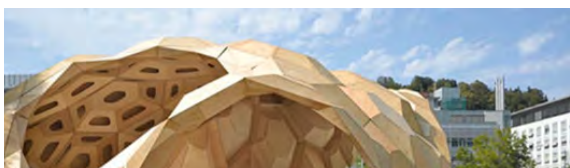
Figura 34. Vista exterior cubierta, Research Pavilion 2011
