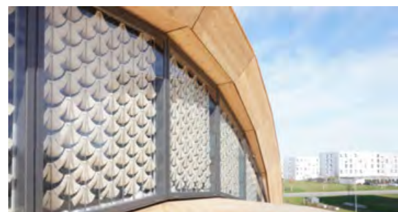
Figura 49. Hojas tensadas higro-térmicamente
