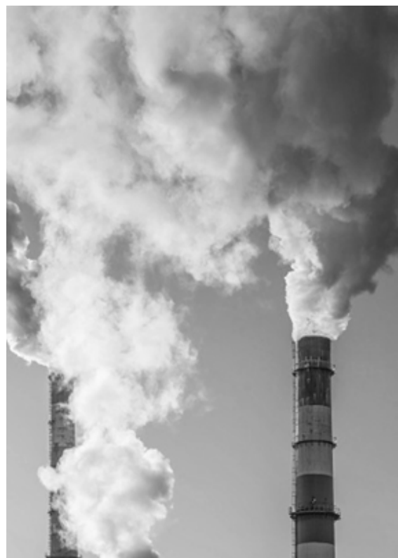
Figura 59. Imagen chimeneas industriales
