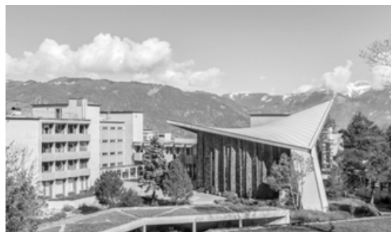
Figura 61. Iglesia en Suiza, cubierta PH de madera
